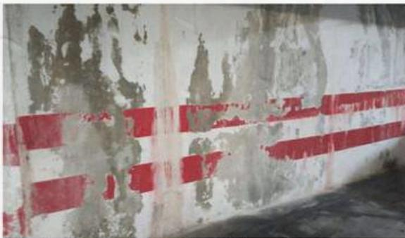
*Ejemplo de humedad por filtración lateral*
